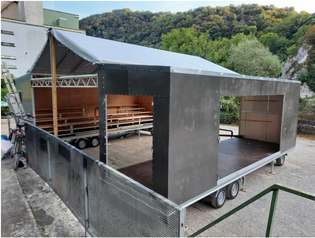
Structure itinérante en cours de construction Juillet 2021
